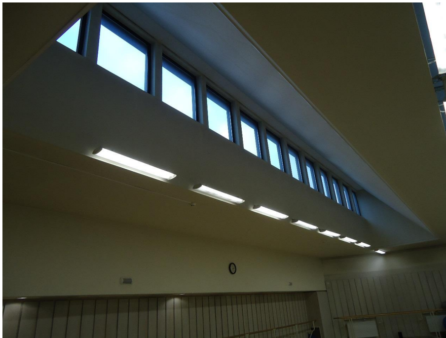
Il. 20. Poprzeczne pasy świetlików, umieszczone w stropie dachowym. Wnętrze jednej z sal prób baletu
